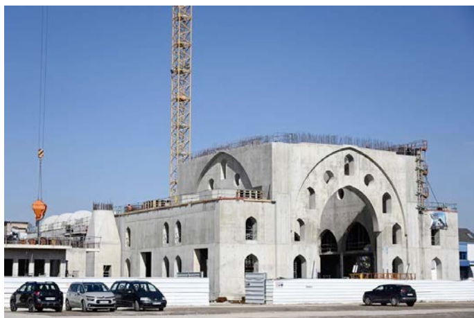
Le chantier de la mosquée Eyyûb Sultan, mercredi à Strasbourg. (Frederick Florin/AFP)
