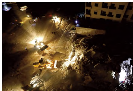
Les secours recherchent des victimes dans les décombres d'immeubles ciblés par l'aviation syrienne, à Idlib, le 4 février 2018.
