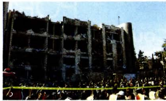
Damas, 17 mars, attentat contre un bâtiment des services secrets
